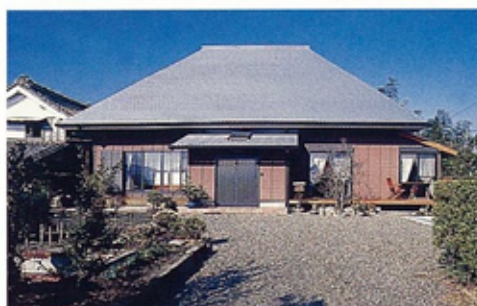
外観 茅葺屋根の形
