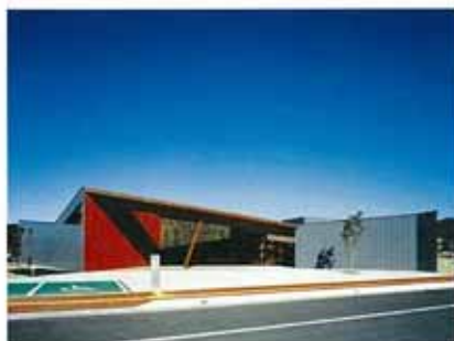
南側外観全景
