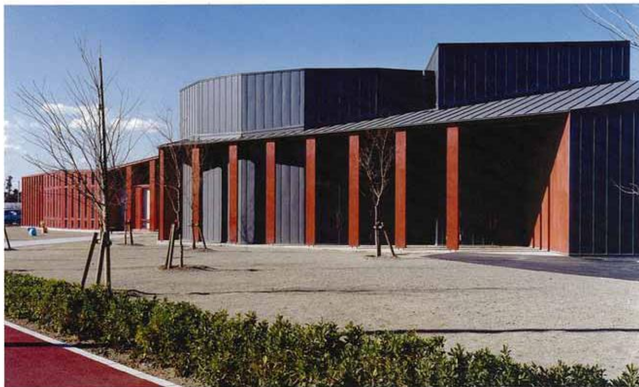
東側外観全景
