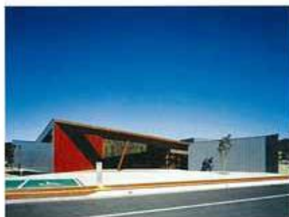
南側外観全景
