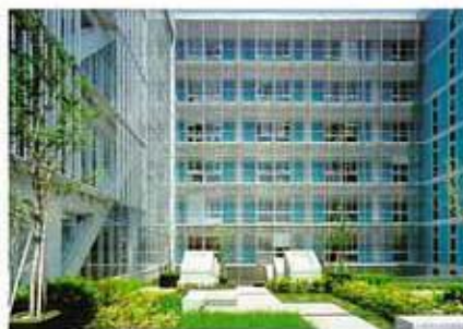
金属断熱サンドイッチパネルはアルミサッシ固定。調堂上部は屋上緑化
