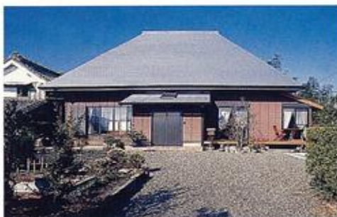
外観 茅葺屋根の形
