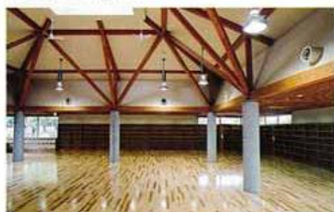
方形の屋根を支える構造材を見えるようにデザイン
