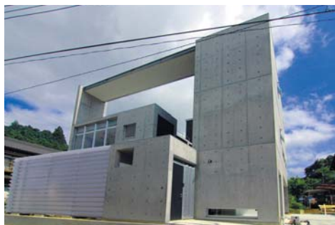
全景 南側ファサード
