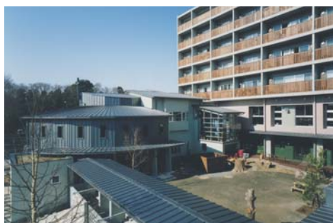
南東公園側全景
