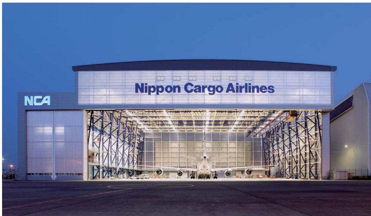
正面より格納庫内を見る(夕景)
