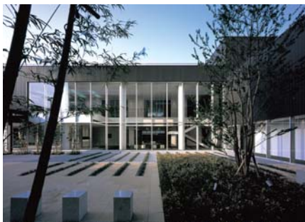
中庭より研修棟を見る
