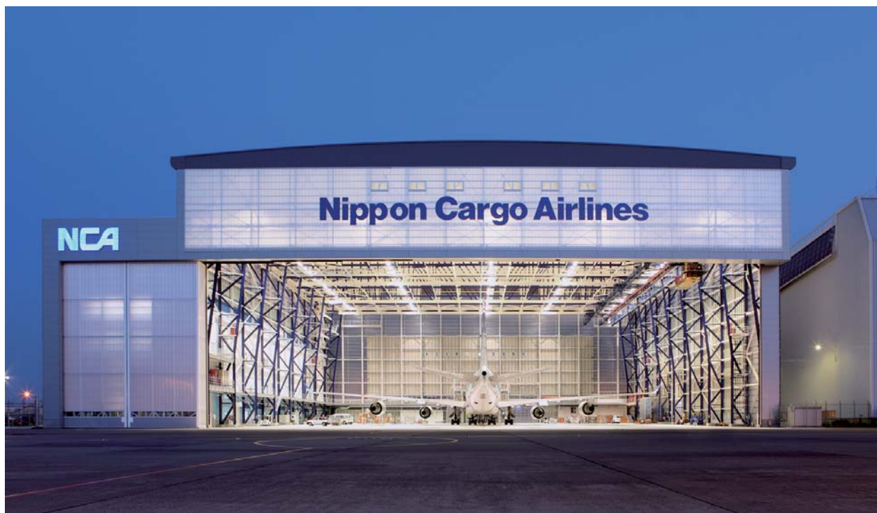
正面より格納庫内を見る(夕景)
