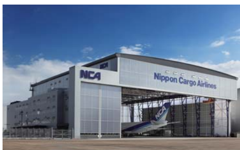
エプロン側全景(大扉開放)
