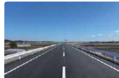
銚子連絡道路(匝瑳市)
