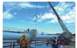
船戸水管橋(印西市)
