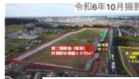
一宮川 河川整備(一宮川第二調節池 40万m³増設など)
