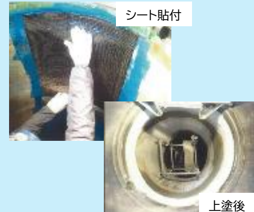
シート貼付 上塗後 炭素繊維シートによる補強状況
