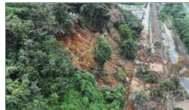
道路・鉄道と沿道斜面の被災
