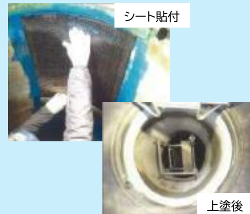
シート貼付 上塗後 炭素繊維シートによる補強状況
