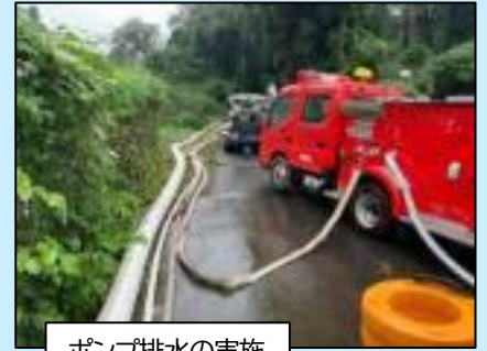
ポンプ排水の実施
