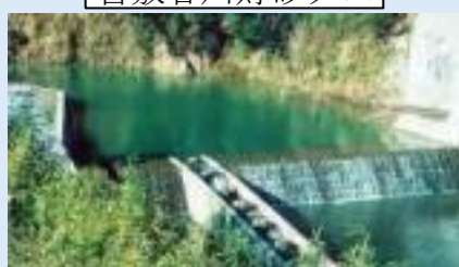
古敷谷川貯砂ダム
