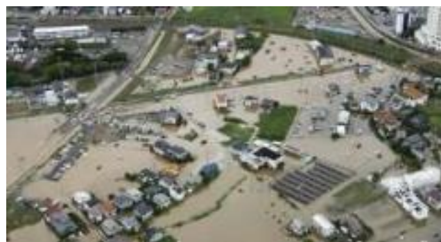
住宅等の浸水被害
