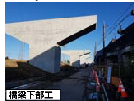
▼写真① (橋梁区間)
