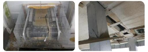
集卵コンベアなどの開口部の隙間を塞ぐ。普段目の届きにくい屋根裏や入気口も点検し、破損があれば補修。
