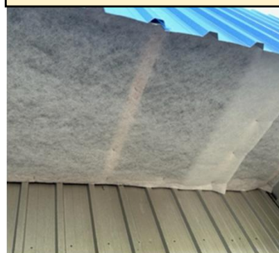
入気口フィルターの設置
