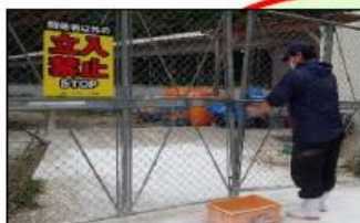
フェンス設置
