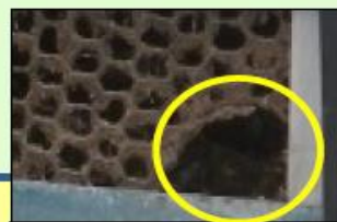
金網等の破損修繕
