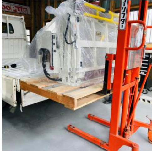
車いすリフト取付の様子
