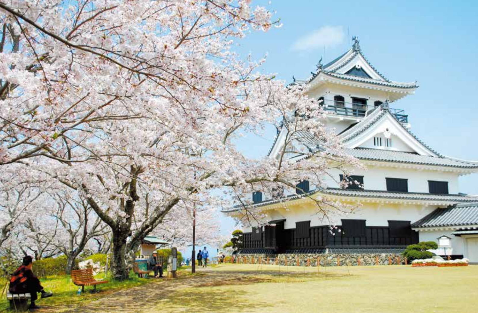
館山城（館山市） 館山城（館山市）
