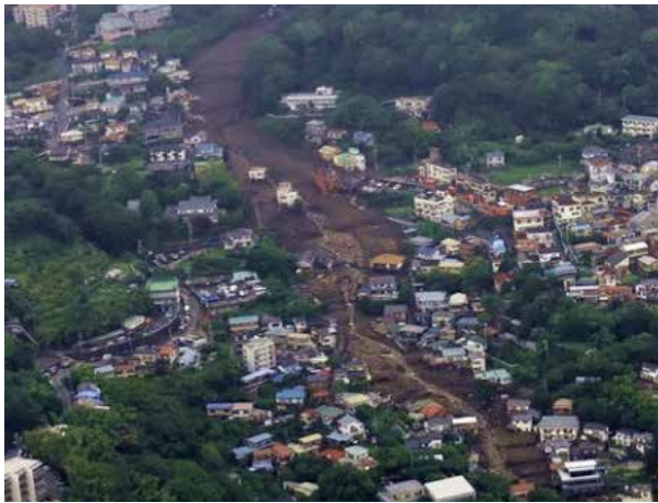
2021(令和3)年7月 静岡県熱海市(死者28人、住宅被害98棟)
