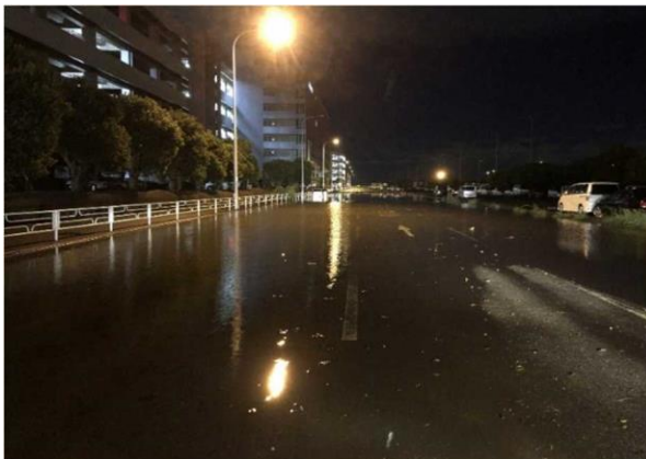
臨港道路浸水
