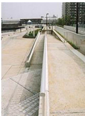
千葉港海岸（船橋地区） 船橋港親水公園のスロープ
