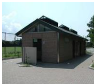
千葉港海岸（千葉北部地区）のトイレ
