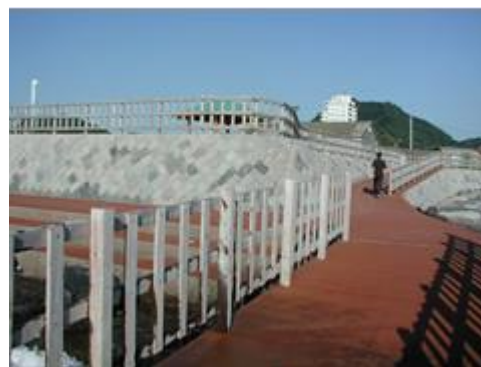
勝山漁港海岸のスロープ
