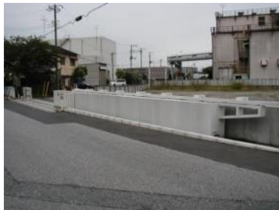
陸閘 [千葉港海岸 (寒川地区)]
