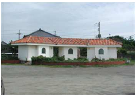
館山海岸（那古地区）のトイレ
