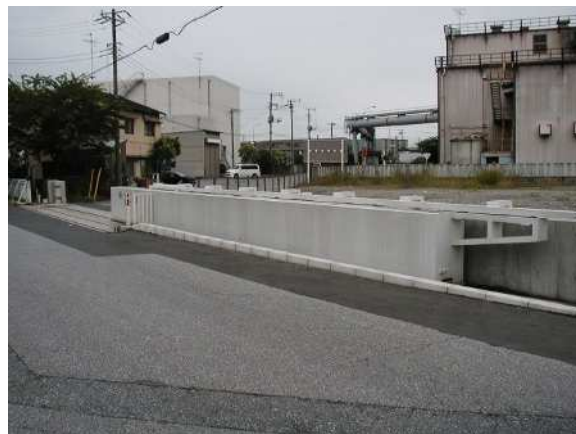
陸閘 [千葉港海岸 (寒川地区)]
