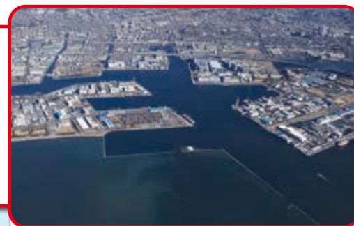
葛南中央地区 Katsunan Central Area
