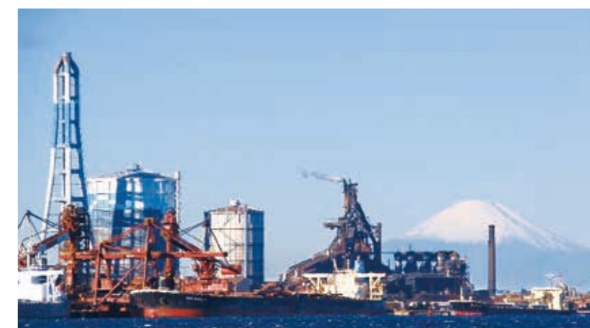
日本製鉄(株)東日本製鉄所 君津地区
