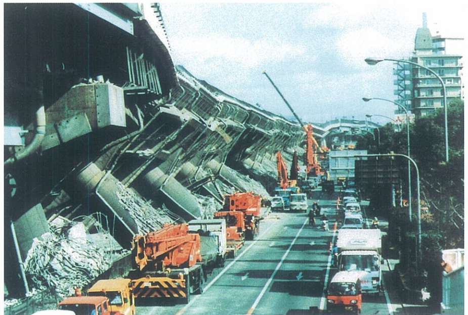
▲ 橋脚から倒れた高速道路
