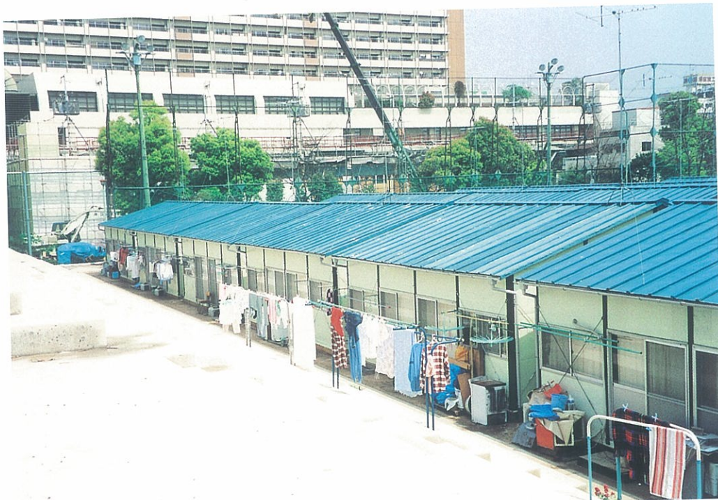
▲避難住民のために建設された仮設住宅（長田区）
