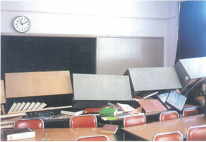
▲ロッカーが転倒した教室
