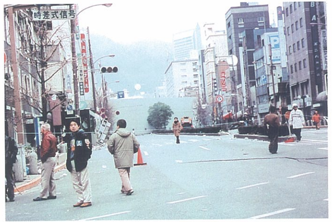
▲ビルの倒壊により、道路が塞がれた中央区加納町
