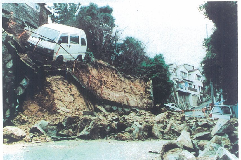
▲崖崩れにより、石垣が崩壊し、落下しそうな車
