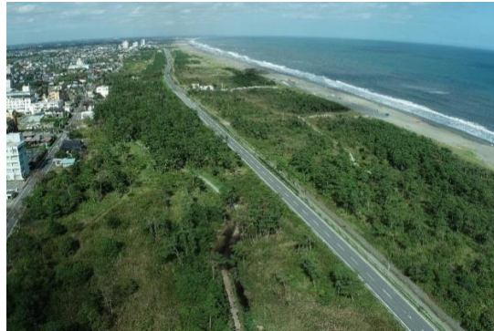
ドローンによる空撮写真
