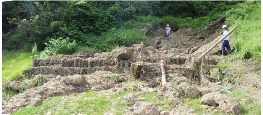
崩落正面から撮影
