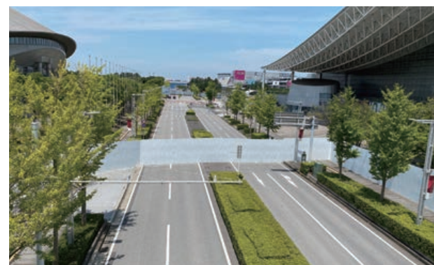
通行止めとされたメッセ大通り。大会時は警備強化のため、幕張メッセの外周に高さ3m程度のセキュリティフェンスが設置された。
