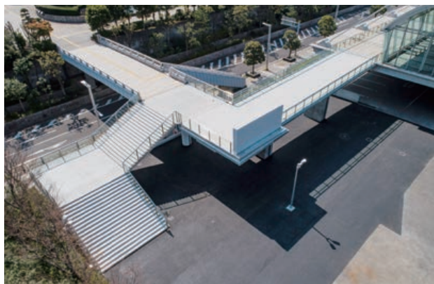
幕張メッセの国際展示場展示ホール9～11とJR海浜幕張駅へ続くスカイウェイをつなぐ連絡デッキが新設された。
