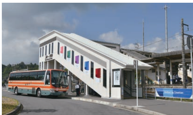
大会時のJR上総一ノ宮駅東口。新設された跨線橋の壁面等にはオリンピック装飾が施された。
