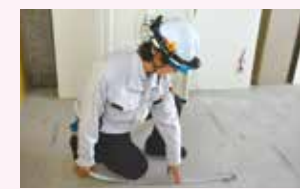
工事に必要な基準線を床などに 描く墨出し作業
