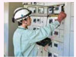
漏電の有無をチェック
