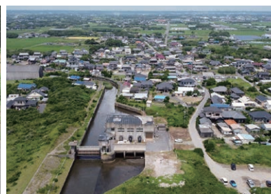
長寿命化対策を実施した農業水利施設 (新堀川排水機場)
