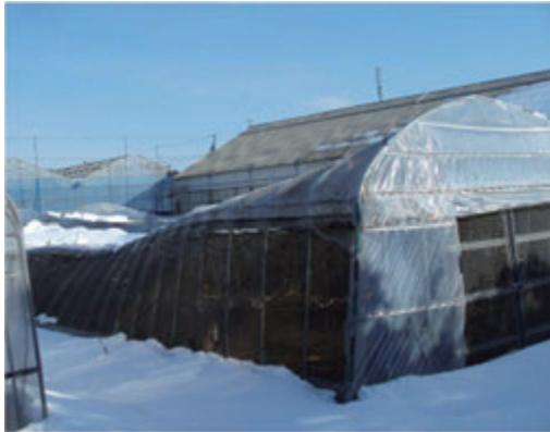
真上から屋根が押しつぶされたように陥没
