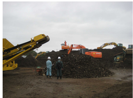
災害廃棄物の仮置場の様子
