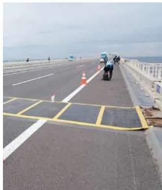
アクアラインの接続部分はマットを敷いて安全確保
