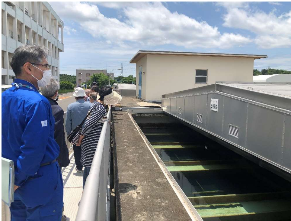
施設見学（浄水場）
