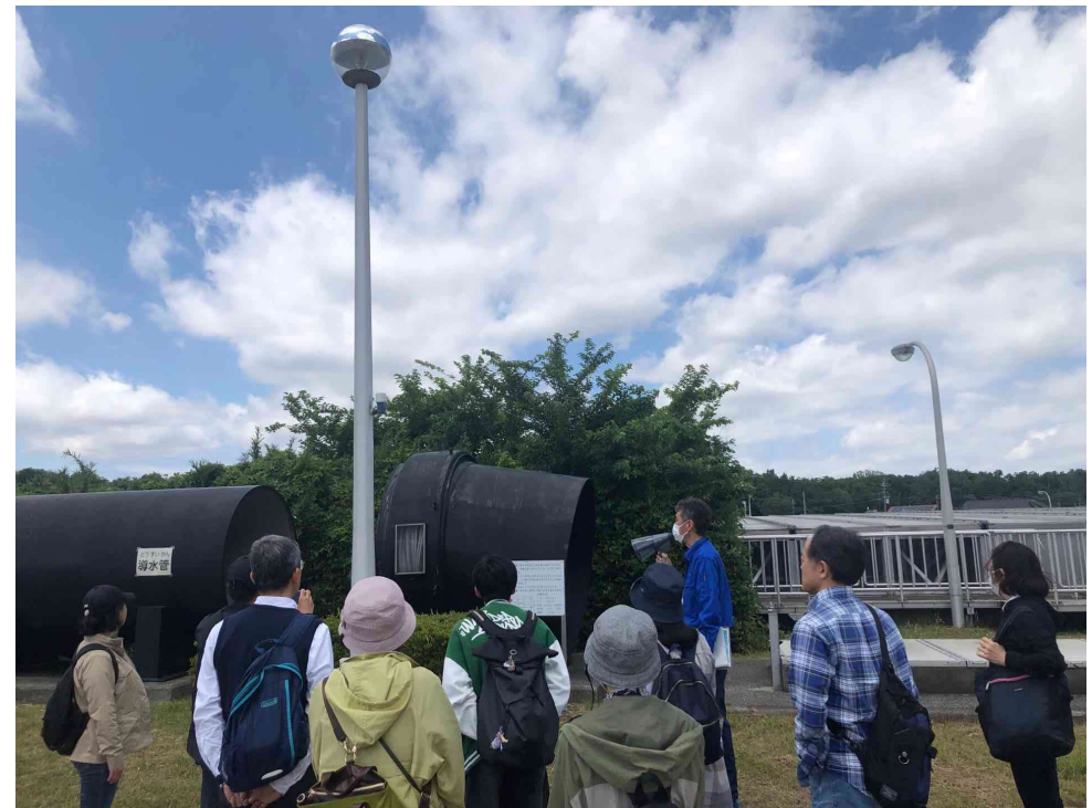
施設見学（浄水場）
