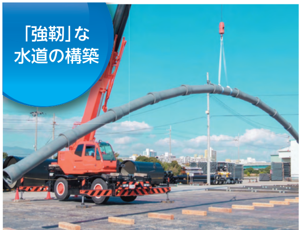
耐震継手管のデモンストレーション(クレーンによる吊り下げ) [提供: 日本ダクタイル鉄管協会]
