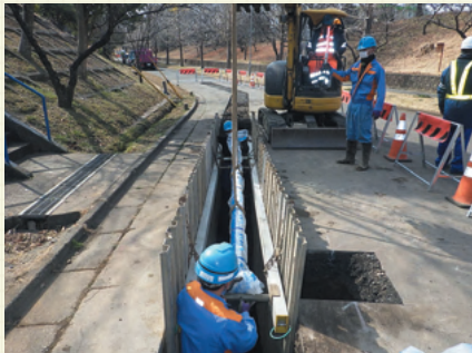
水道管取替工事の様子
