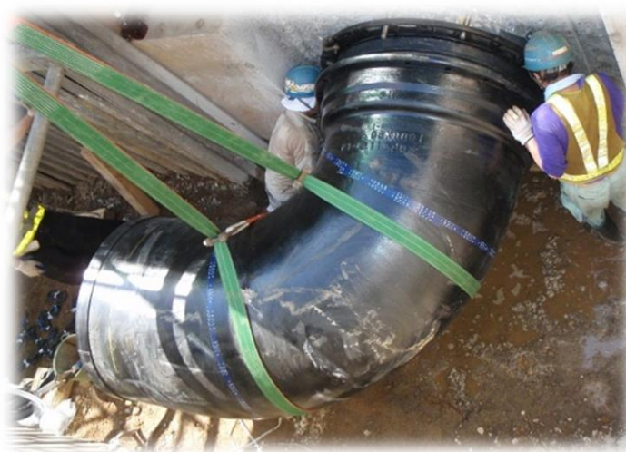
配水管布設替工事
