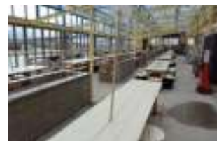
バーベキュー施設
