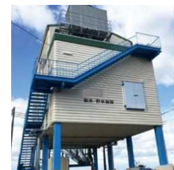
船橋港製氷貯氷施設
