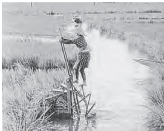
あしぶ しき すいしゃ おく 足踏み式の水車で水田へ水を送っているようす (1961(昭和36)年ごろの香取地域(旧佐原市))
