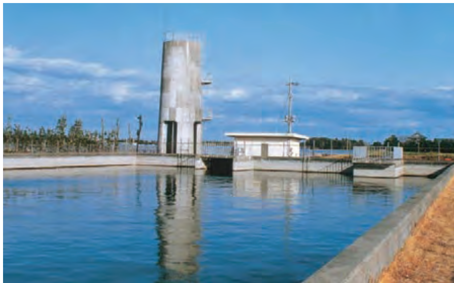
東総用水のファームポンド (水量調整用の小溜池)
