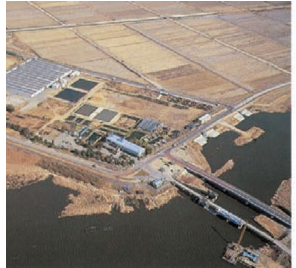
手賀川浄化施設
