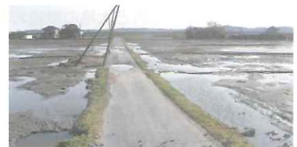
写真5 香取市一分目新田での1.5mを超える地盤沈下
