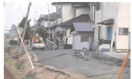
写真4 旭市野中での地波と家屋の傾動
