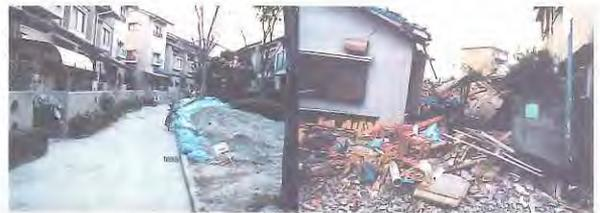
写真7 阪神－淡路大震の際の戸建て住宅の被害の違い。右は沖積低地、左は埋立地
