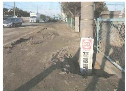
写真3 千葉市美浜区新港での電柱の沈み込み
