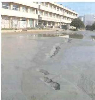
写真1 千葉市美浜区高浜三小校庭での噴砂
