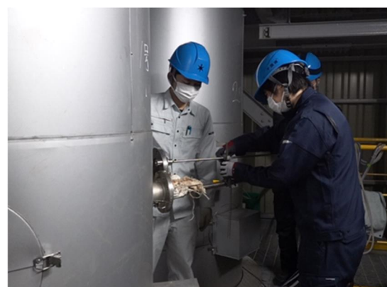
写真 4 煙道での測定の様子
