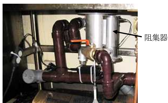
図１ コンビニ設置阻集器（シンク下）
