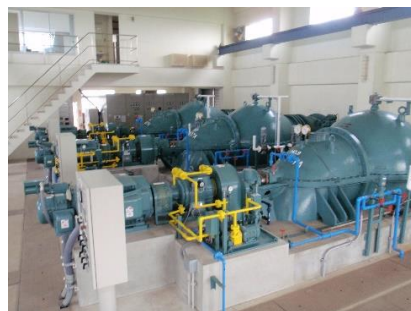
例) 排水機場の整備
