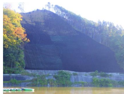
例) 山崩れや地すべり被害地の復旧
